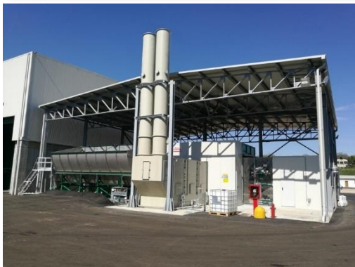
SECHEUR DIGESTAS PHASE SOLIDE
